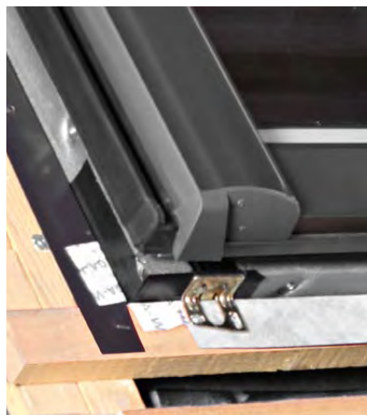
Wykonanie uszczelnienia wodoodporną taśmą dookoła okna.
