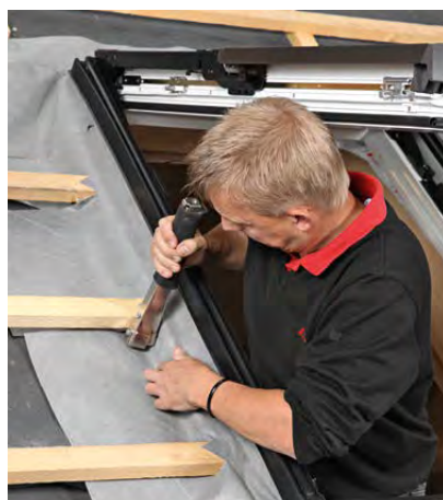
Montaż na łąkach montażowych - połączenie wodoszczelne.
