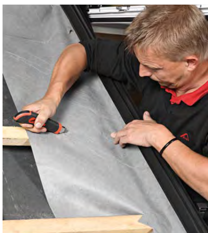
Montaż na łąkach montażowych - połączenie wodoszczelne.
